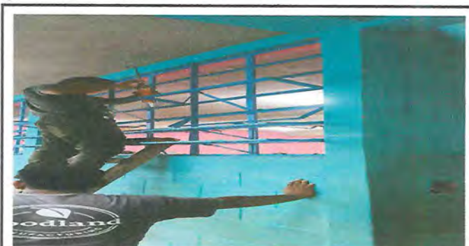
Foto 6: Instalación de vidrios en ventanales.
