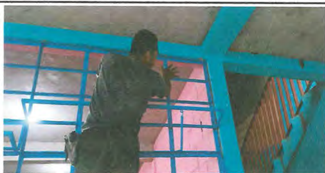
Foto 5: Instalación de vidrios en ventanales.
