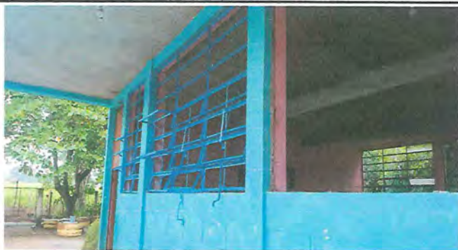
Foto 1: Desmontaje y mantenimiento a ventanales.
