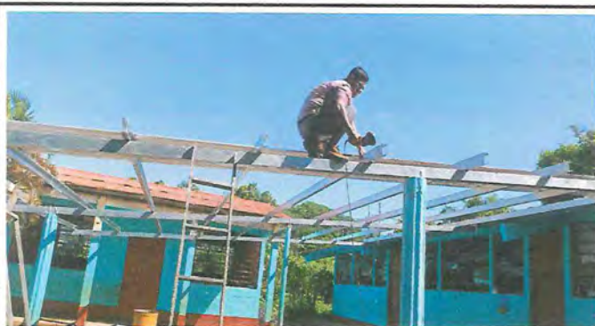
Foto 3: Cambio de estructura metálica.
