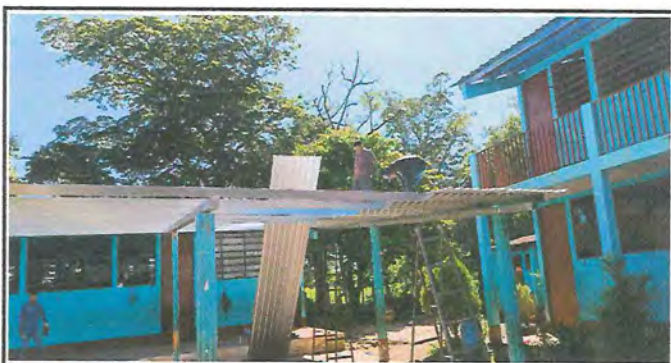
Foto 4: Cambio de laminas.
