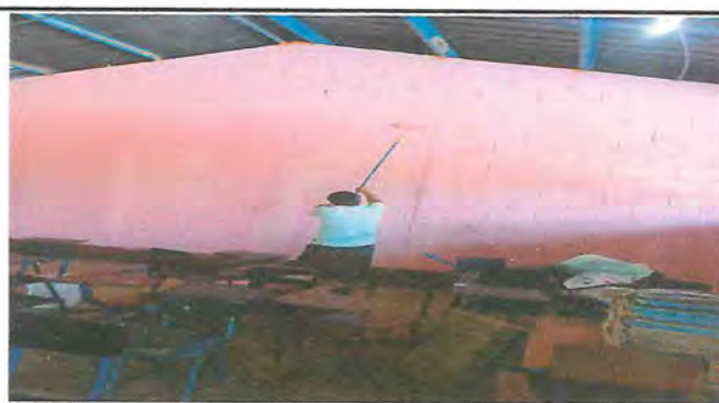
Foto 4: Pintura en salones.
