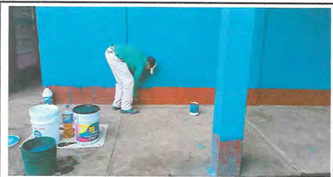
Foto 3: Pintura en salones.
